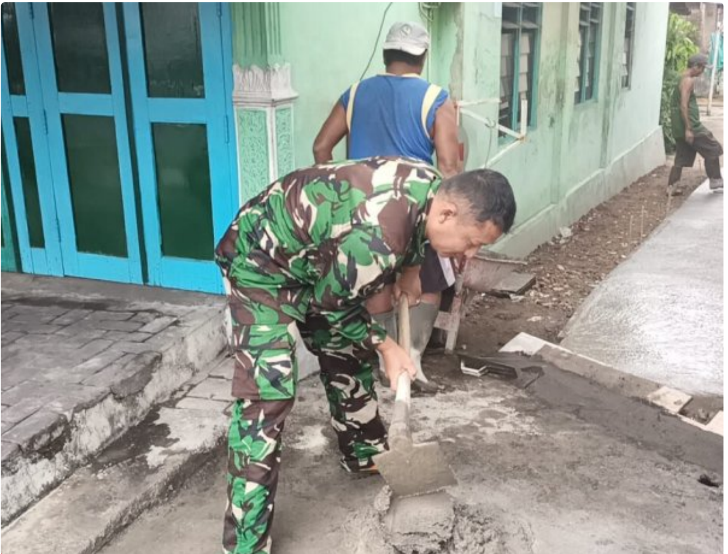
Ringankan Warga Binaan, Babinsa Koramil Prambanan Bantu Perbaiki Jalan Gang
