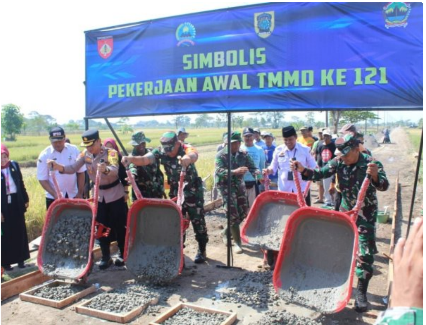
Pengecoran Perdana TMMD Reg 121 dilakukan Forkopimda Klaten
