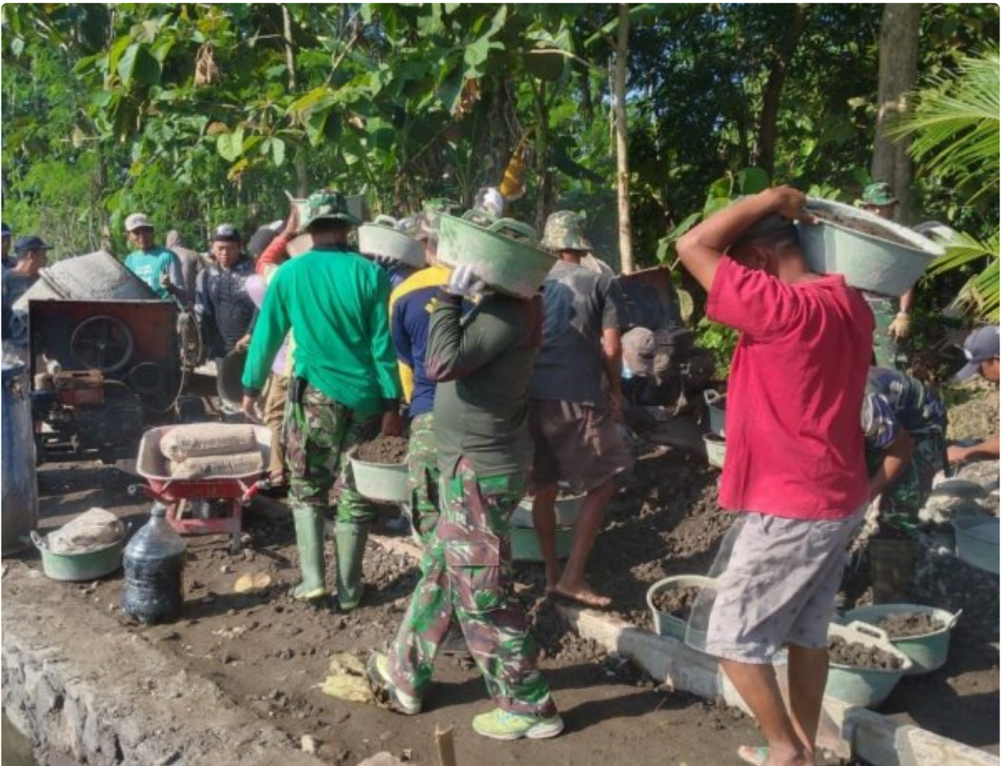
Babinsa Kodim Klaten Gotong Royong Betonisasi Jalan Program TMMD
