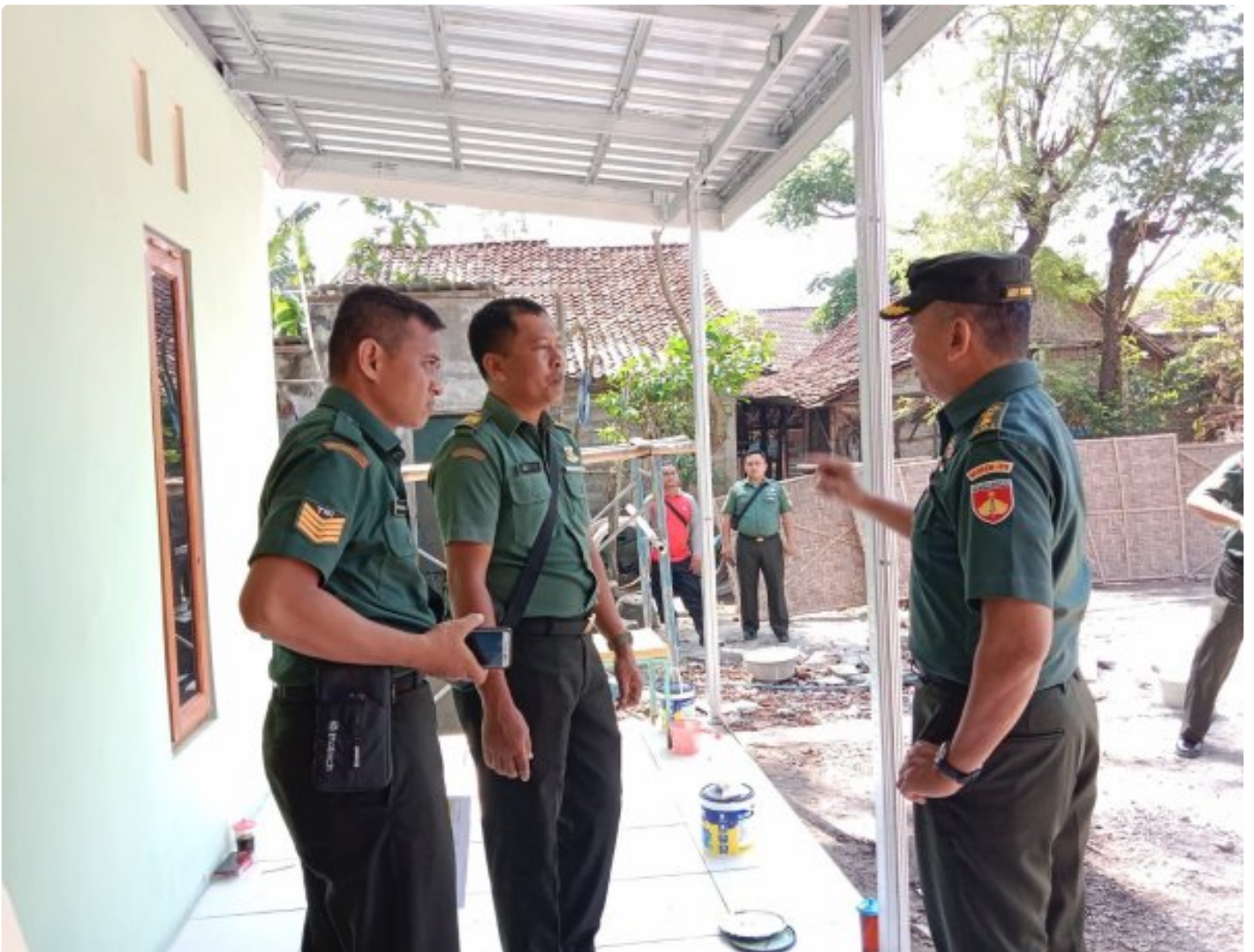
Kasiter Korem 074/Warastratama Kunjungi Pembangunan RTLH Di Wilayah Kodim 0723/Klaten
