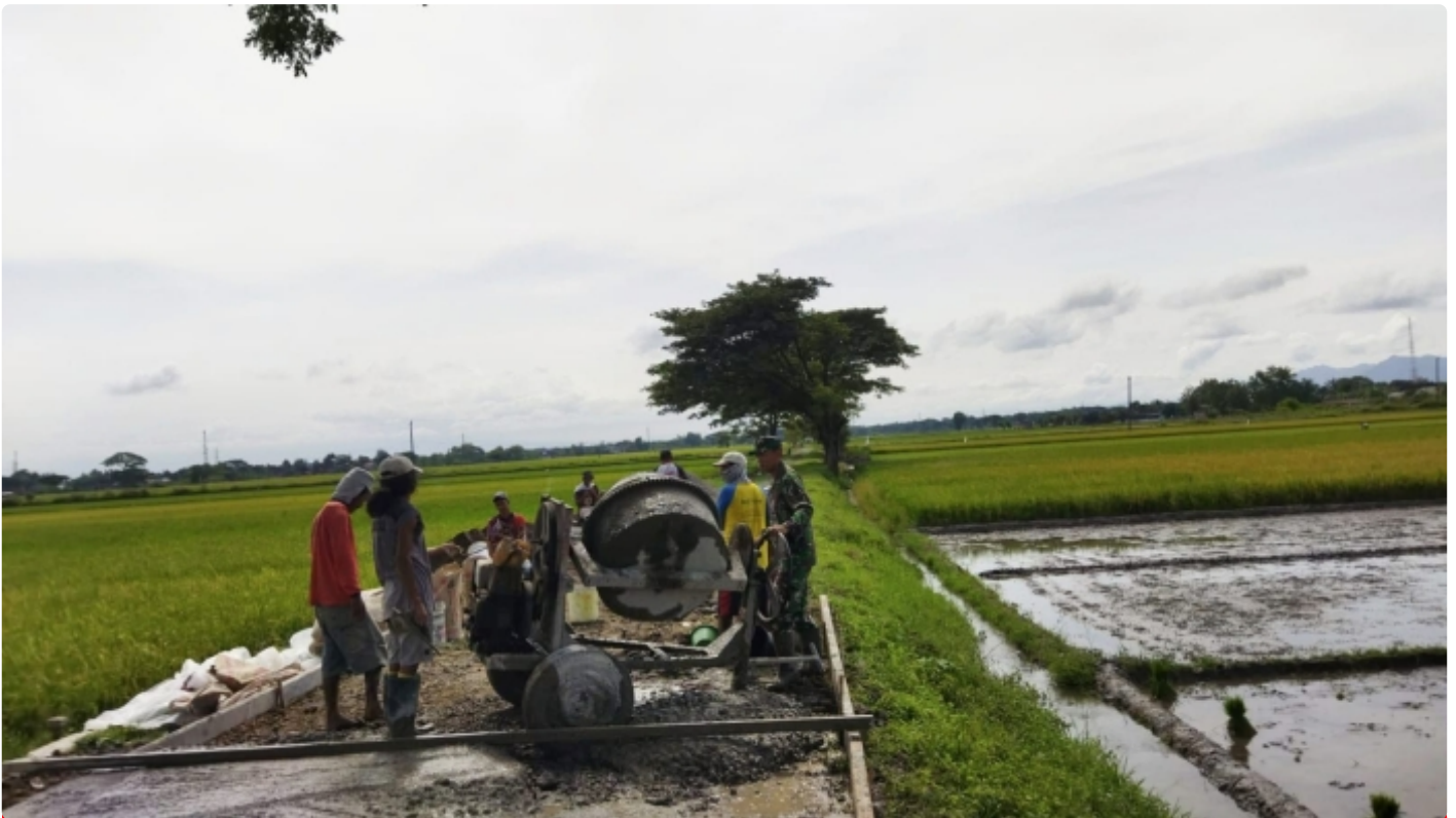
Gotong Royongnya Babinsa Juwiring Bantu Betonisasi Jalan
